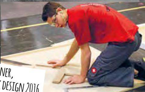
// Floor Laying / Bodenleger
