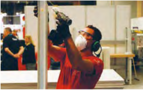
// Plastering & Dry Wall Systems / Stuckateur und Trockenbau
